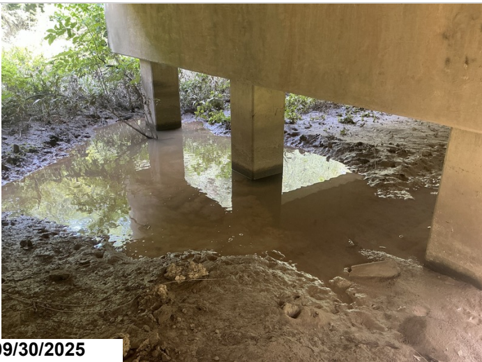
Bent 2 piles 1&2 local scour CS2
