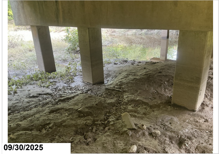
Bent 3 pile 1 local scour
